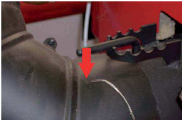
Установка датчика температуры дымовых газов
